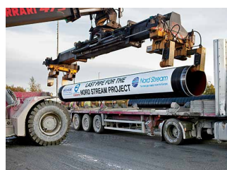
Det sidste rør på vej til Mukran.
