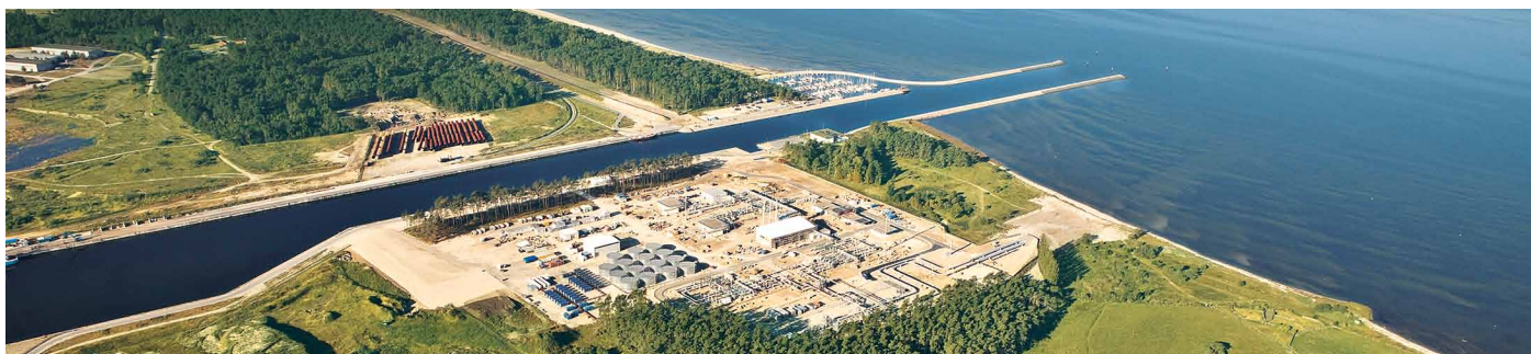
De to rørledninger i Nord Stream-rørledningssystemet når land i Lubmin. På ilandføringsanlægget bliver naturgassen rensat, målt og om nødvendigt tilpasset til rette temperatur før den transporteres videre.
