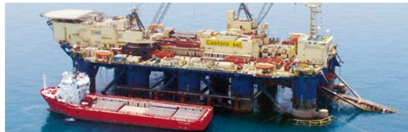
Anlægsarbejdet af den første rørledning er planlagt til at påbegynde i foråret 2010.
