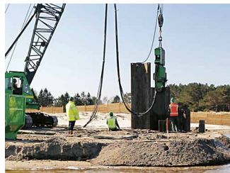
Stålpæle drevet ned i jorden.
