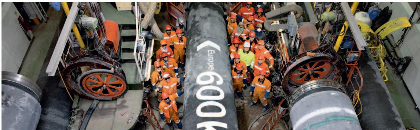
Midt i november nåede Nord Stream halvvejs på linje 1. Denne milepæl blev fejret ombord på Castoro Sei, da et rørsegment med mærket "600 km" blev svejset på rørledningen. I midten af december er 60 procent af linje 1 færdiggjort.
