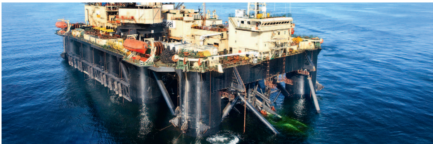
Her ved 60 procent af linje 1 af Nord Streams rørledningssystem var færdiggjort i midten af december 2010. Det primære rørledningsfartøj Castoro Sei (på billedet herover) ligger i øjeblikket rørledning i danske farvande. Samtidig ligger Solitaire rørledning i finske farvande.
