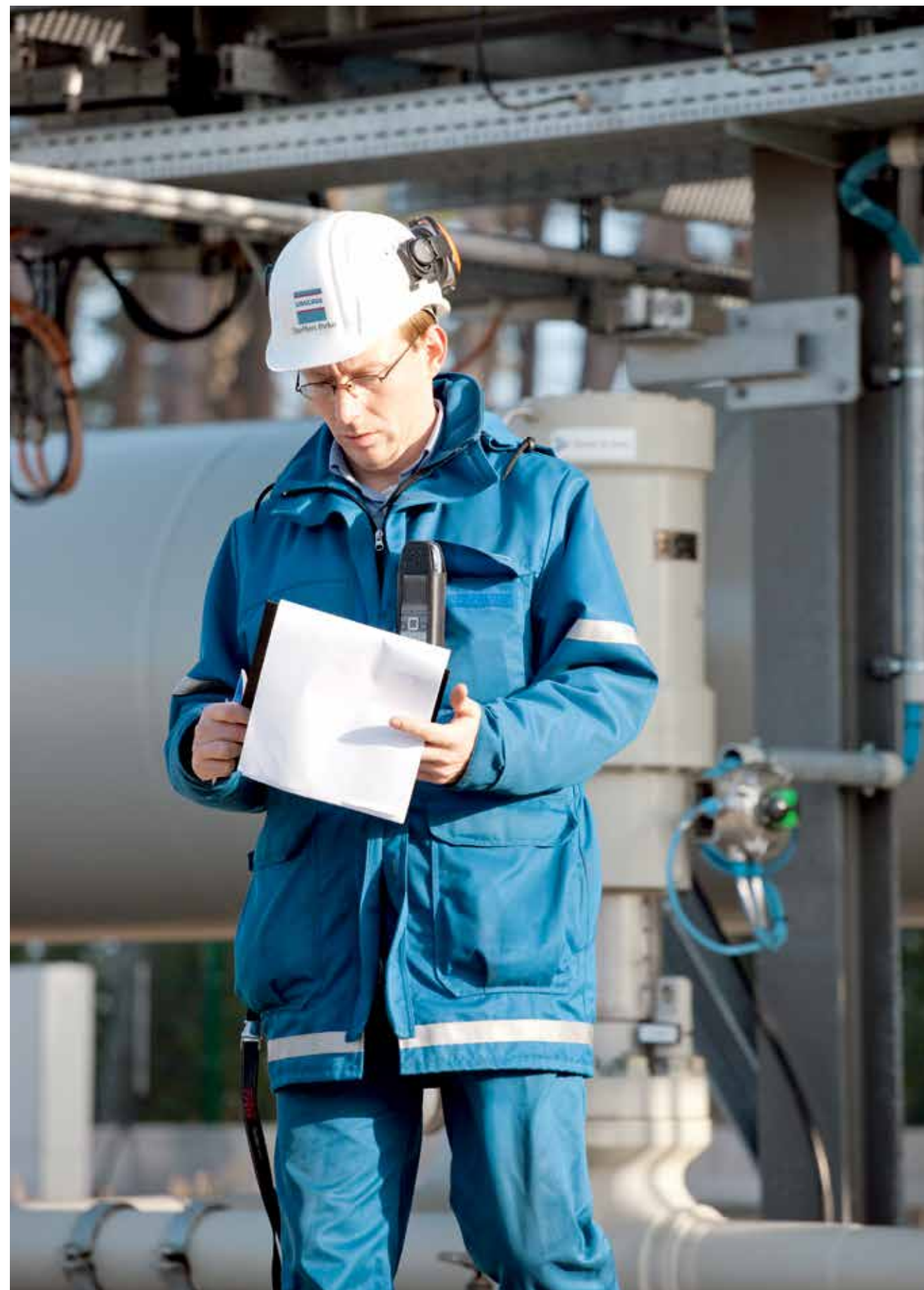
За управление объектами в Любмине, не входящими в газопровод «Северный поток», отвечает компания GASCADE Gastransport. Во время регулярных обходов ее сотрудники визуально осматривают сооружения, проверяют, в частности, давление и температуру запорной арматуры. Сотрудники имеют при себе детекторы газа для обеспечения своей безопасности.
