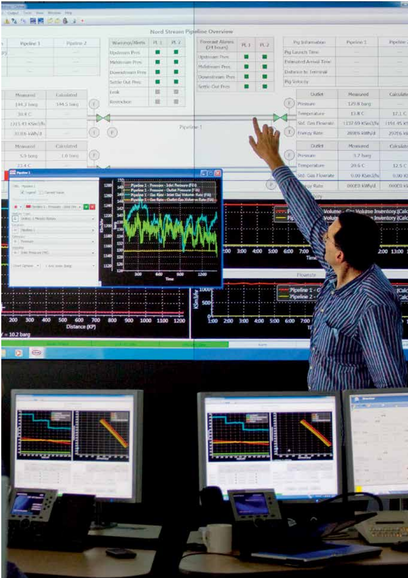
Работа газопровода «Северный поток» отслеживается и контролируется в центре управления Nord Stream в швейцарском городе Цуг. К центру управления подключены система управления и связи, а также береговые сооружения в России и Германии.
