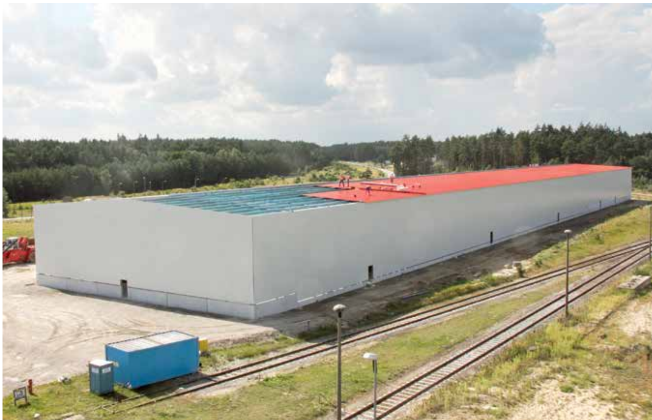
Склад расположен на территории промышленного и энергетического центра в Любминер хайде. Здесь хранятся 450 запасных труб. В том случае, если возникнет необходимость ремонта газопровода в течение 50-летнего срока службы, трубы можно будет быстро доставить в ближайший порт. Конструкция склада обеспечивает достаточное проветривание труб и свободный доступ для визуального осмотра.
