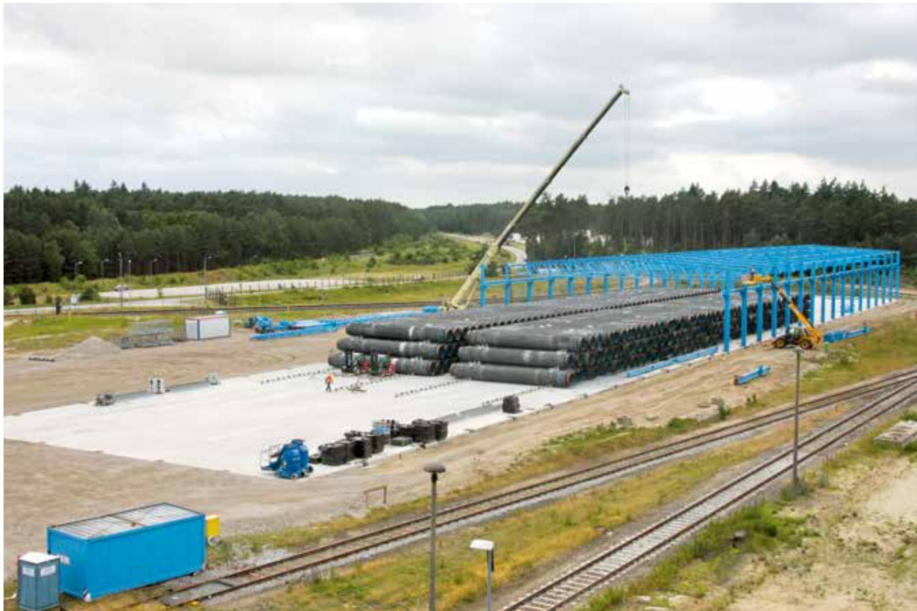
Недалеко от берегового участка газопровода в Германии Nord Stream построил склад запасных частей и труб. Строительство началось в апреле 2012 и закончилось в августе 2012 г. Каркас склада был возведен вокруг уже уложенных в штабели труб.
