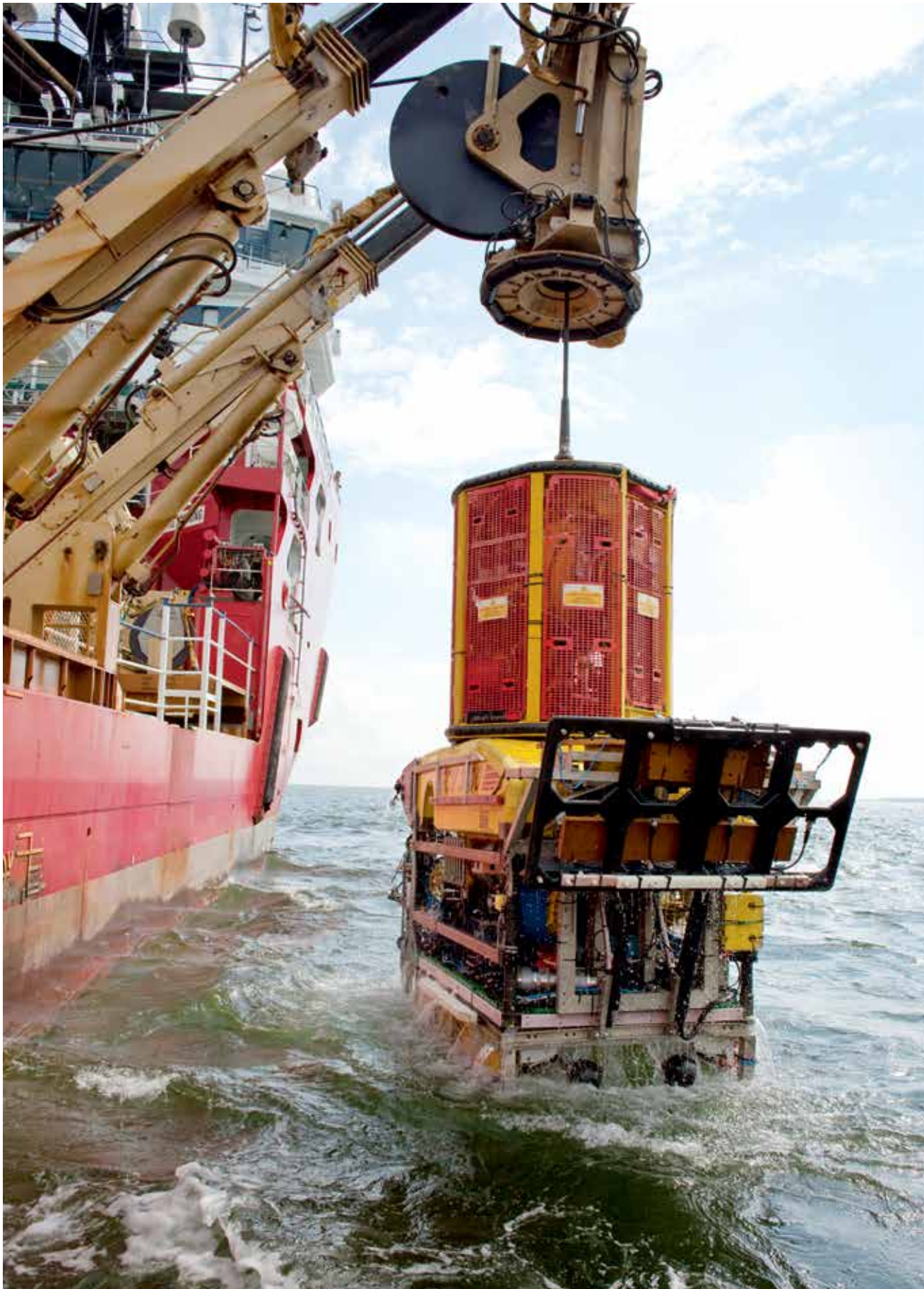
Внешнее обследование первой нитки началось в российских водах в июне 2012 г. В ходе обследования судно тянет вдоль трассы дистанционно управляемый аппарат, сканирующий газопровод с помощью подводных камер и датчиков. Определяется точное положение газопровода на дне и оценивается необходимость дополнительных работ (например, подсыпки гравия для придания дополнительной устойчивости).
