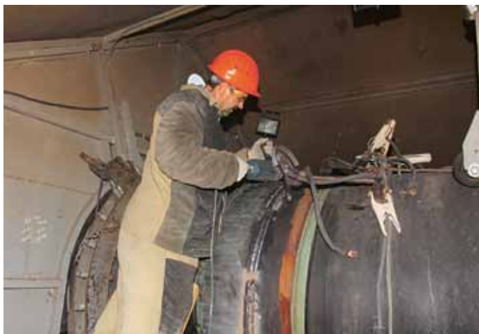
Feinschliff an der letzten Verbindungsschweißnaht für den ersten Gastransport.
