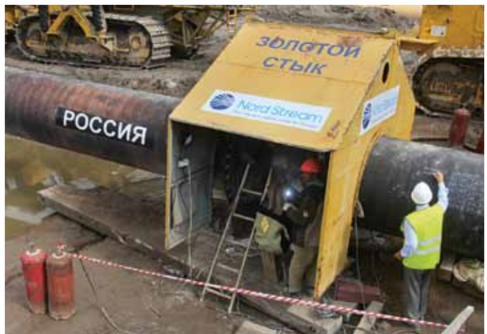
Die Nord Stream-Pipeline wird mit den Einrichtungen an Land verbunden.
