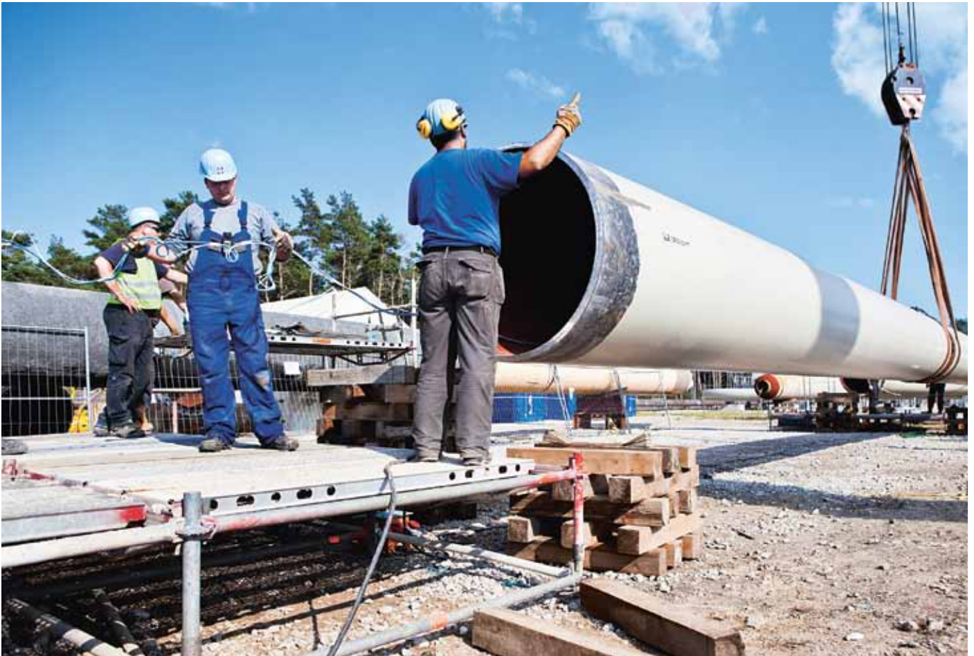
Das auf den Millimeter zugeschnittene Verbindungsstück zwischen dem wasser- und dem landseitigen Teil des ersten Pipeline-Strangs wird genau positioniert.
