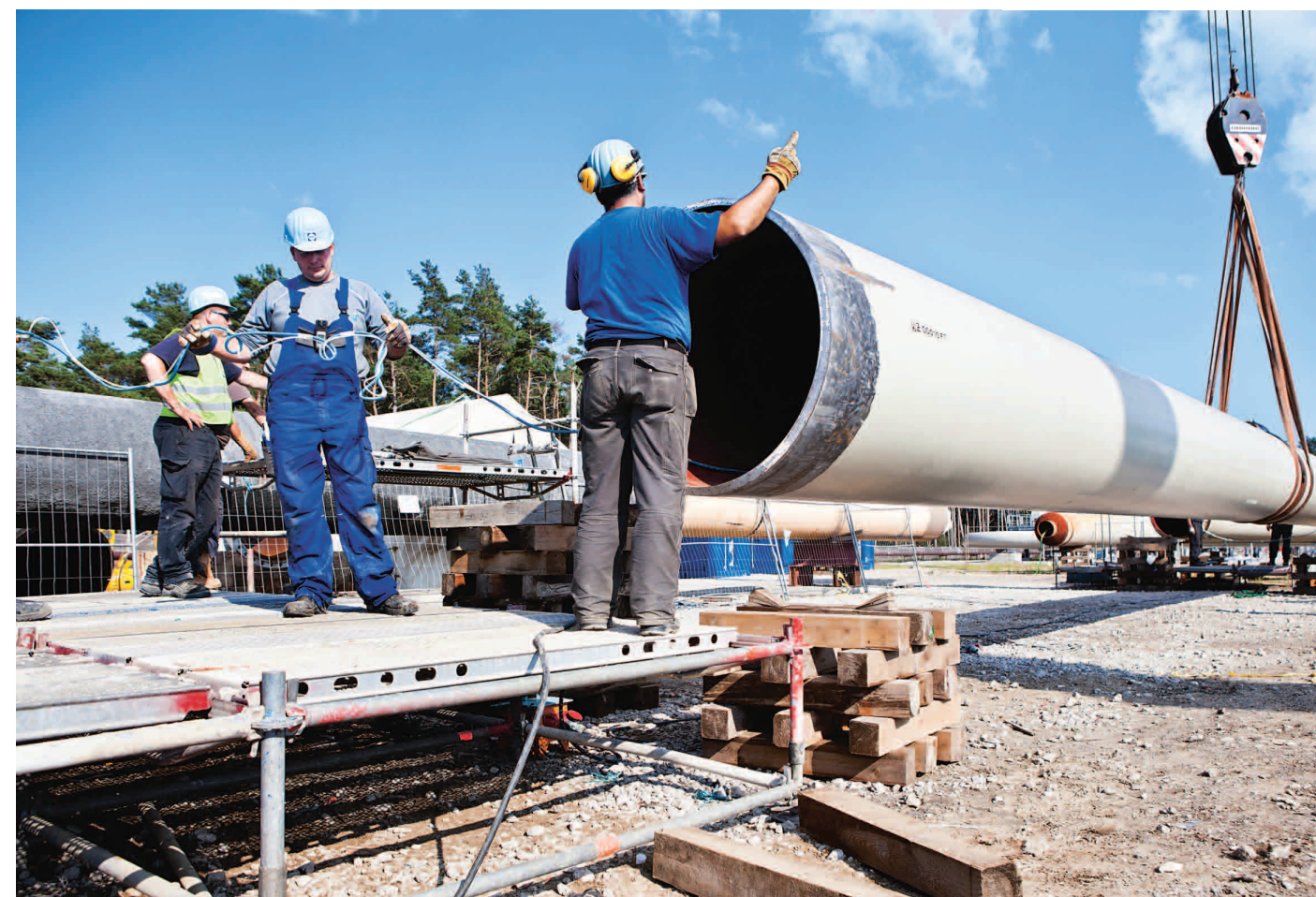
Любмин: Участок трубы длиной 25 м и весом 21 т установлен между морским и береговым участками первой нитки газопровода.
