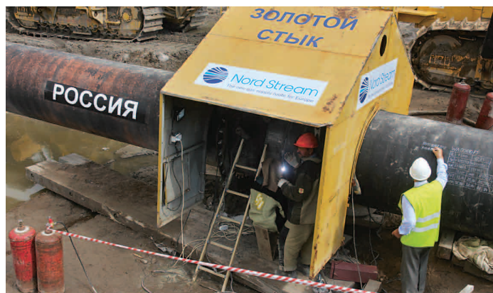
Бухта Портовая: сварка «золотого» стыка успешно завершена 19 августа.
