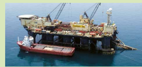
Die Castoro Sei leistet den Löwenanteil der Verlegearbeiten.
