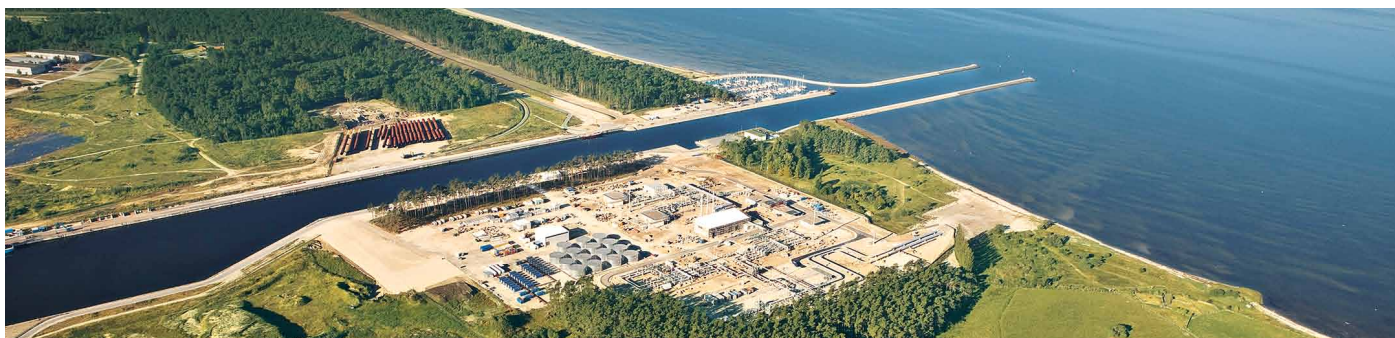
Die zwei Leitungsstränge der Nord Stream-Pipeline erreichen bei Lubmin das deutsche Festland. In der Anlandestation wird das Erdgas gereinigt, gemessen und falls nötig für den Weitertransport vorgewärmt.
