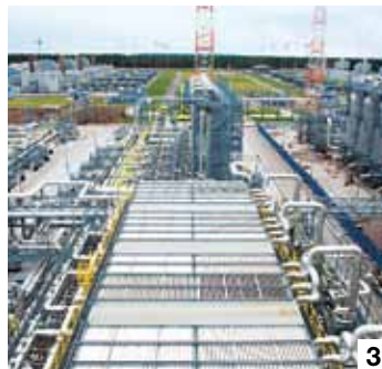
1) und 2) Eine Gaspumpeinheit resp. ein Kompressor, angetrieben durch einen Rolls Royce-Motor. 3) Im Vordergrund die Gasaufbereitungsanlage, dahinter die acht Kompressorereinheiten. 4) und 5) Die Aufbereitungsanlage entfernt Kondensate aus dem Gas, das durch die Gryazovets-Wyborg-Pipeline angeliefert wird.
