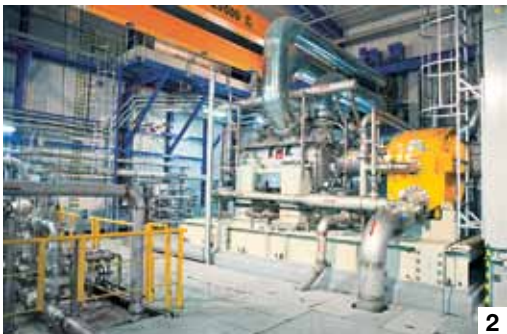
1) und 2) Eine Gaspumpeinheit resp. ein Kompressor, angetrieben durch einen Rolls Royce-Motor. 3) Im Vordergrund die Gasaufbereitungsanlage, dahinter die acht Kompressorereinheiten. 4) und 5) Die Aufbereitungsanlage entfernt Kondensate aus dem Gas, das durch die Gryazovets-Wyborg-Pipeline angeliefert wird.
