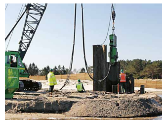
Spundwände werden eingebracht.
