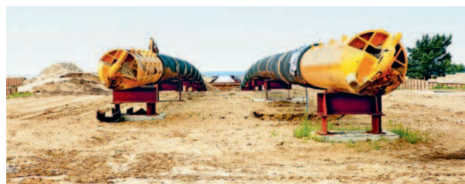
2010 wurden viele Meilensteine erreicht, darunter die Anlandung der beiden Pipelinestränge in Deutschland (oben) und in Russland.
