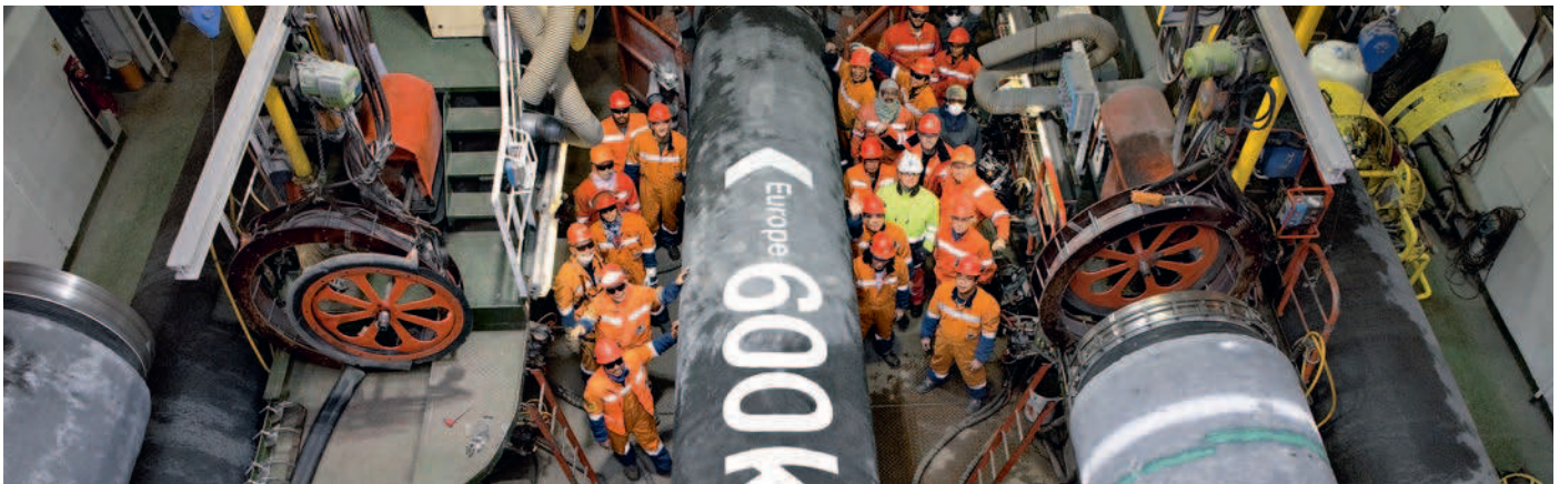
Mitte November vollendete Nord Stream die Hälfte des ersten Leitungsstrangs. An Bord der Castoro Sei wurde dies gefeiert, indem ein Rohr mit der Beschriftung „600 km“ an den Pipelinestrang angeschweißt wurde. Mitte Dezember waren rund 60 Prozent des ersten Strangs fertiggestellt.
