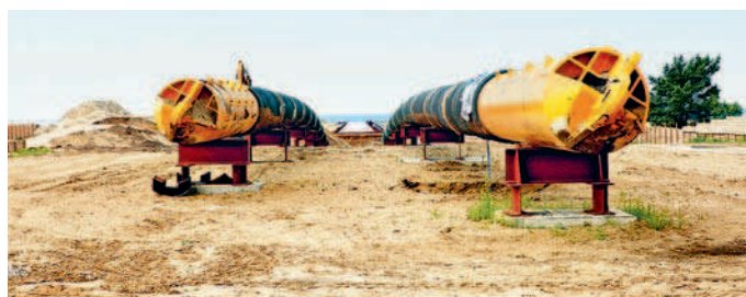
Важные этапы строительства в 2010 году: протаскивание обеих ниток газопровода на берег в России и Германии (на фото).
