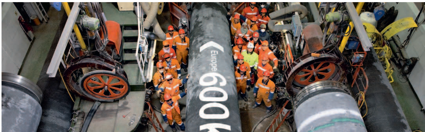
К середине ноября компания Nord Stream построила половину первой нитки газопровода. В честь этого события на трубоукладочном судне Castoro Sei к газопроводу была приварена труба с надписью «600 км». В середине декабря была проложена уже около 60 процентов первой нитки.
