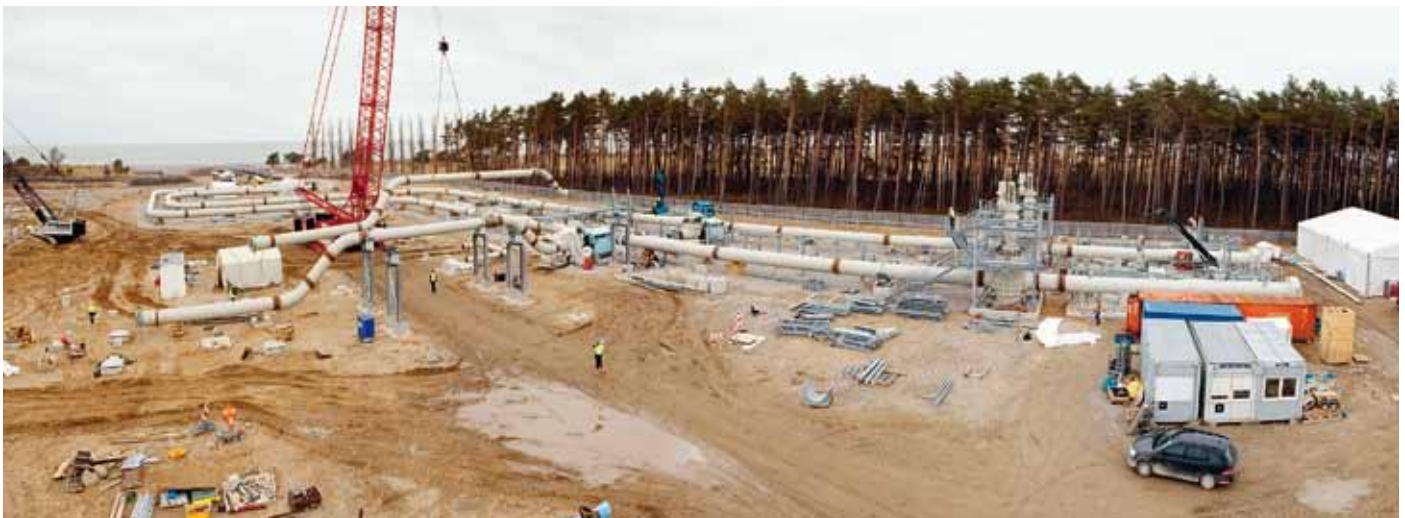
Die Arbeiten im Greifswalder Bodden waren Ende des Jahres abgeschlossen, die landseitigen Bauarbeiten dauern weiter an.
