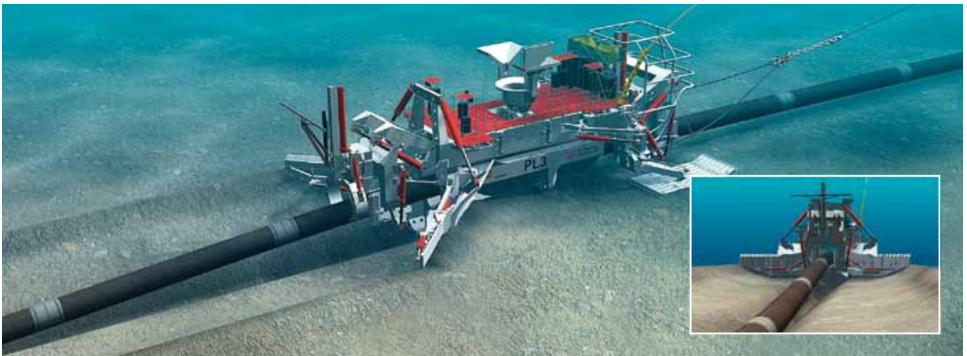
Der PL3 hebt die Pipeline auf Laufrollen und wird dann von der Far Samson vorwärts gezogen. Es entsteht ein Graben, in den die Pipeline zu liegen kommt.
