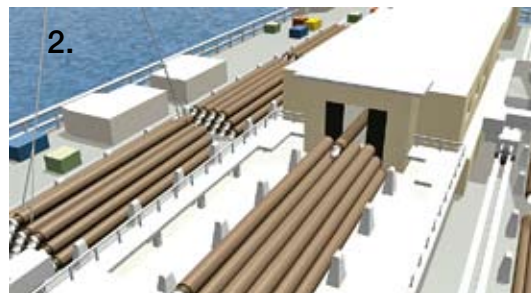
2. Beginn der Bauarbeiten Jedes Rohr wird nach dem Transport geprüft und in eine geschlossene Produktionseinrichtung für das Verschweißen der Rohre zu einer Pipeline eingeführt.
