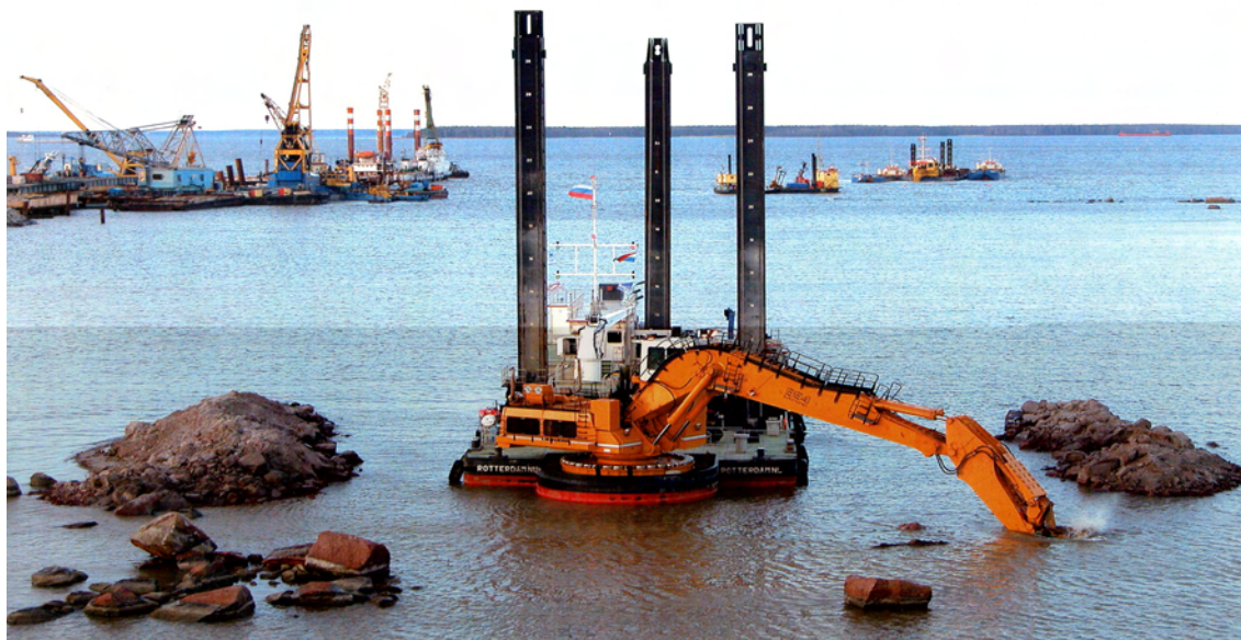
Рис. 3.1 Гидравлический дноуглубительный экскаватор на понтоне
