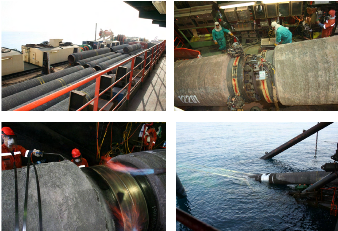
Abbildung 4.4 Verschiedene Ansichten von Pipeline-Verlegungsaktivitäten auf dem Verlegeshipf Castoro Sei . Von links oben nach rechts unten: Leitungsrohre an Deck der Castoro Sei , Zusammenschweißen einzelner Leitungsrohre, Aufbringen der Montagestoßbeschichtung auf der Schweißnaht und Pipeline, die am Heck des Verlegeshipfes ins Wasser eintritt
