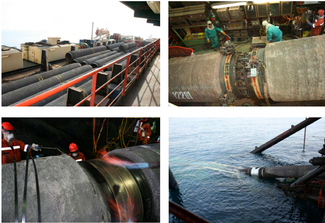
Kuva 4.4 Putkenlaskutoimintojen eri puolia putkenlaskualuksella Castoro Sei . Myötäpäivään ylhäältä vasemmalta: Virtausputki Castoro Sei -aluksen kannella; yksittäisten linjaputkien hitsausta; hitsatun liitoksen peittävän eristeen valmistelua; putkilinjan lasku veteen putkenlaskualuksen takaosasta
