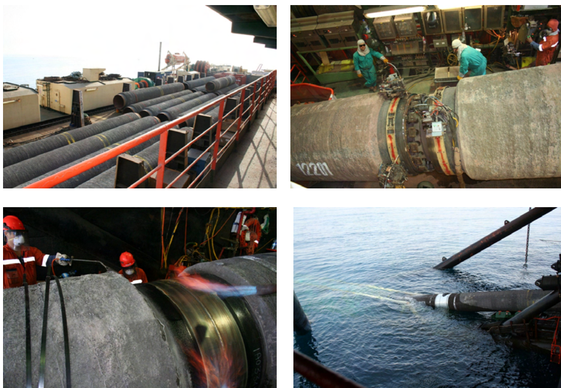
Рис. 4.4 Различные виды работ по укладке труб на трубоукладочной барже « Castoro Sei ». По часовой стрелке сверху слева: Секция трубы на палубе « Castoro Sei »; сварка отдельных секций труб; подготовка покрытия стыков поверх сварного шва; и трубопровод, погружаемый в воду позади трубоукладочной баржи
