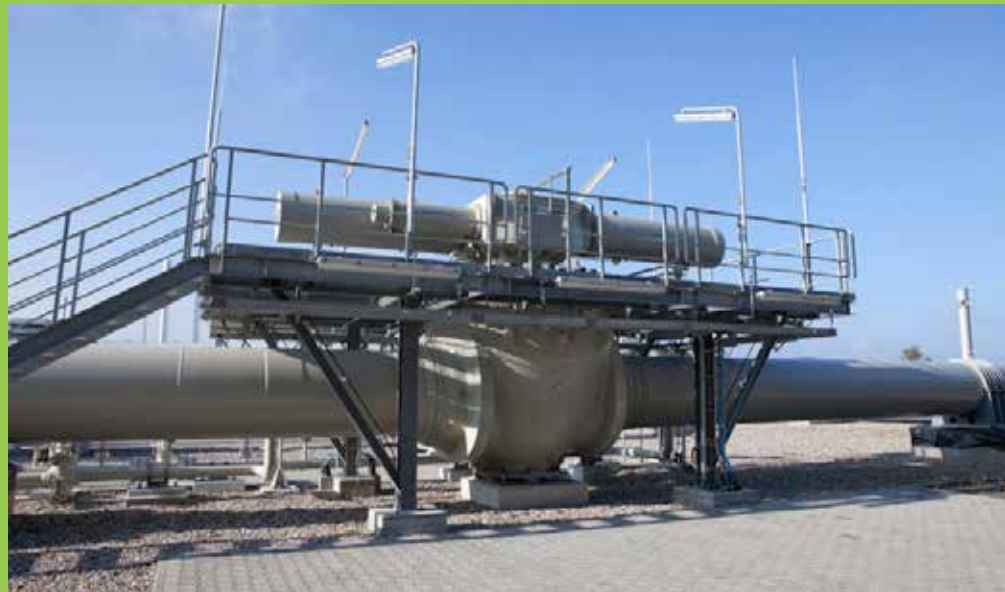
Die Sicherheitsabsperrentile sind rund viereinhalb Meter hoch. Bei einem Notfall unterbrechen sie sofort den Strom des Gases in der Pipeline.
