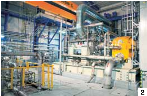
1 ja 2: Kaasunpumpausyksikkö, eli kompressori, jonka voimanlähteenä on Rolls Royce -moottori. 3: Edessä kaasunkäsittelylaitos ja taustalla kahdeksan kompressoriyksikköä. 4 ja 5: Kaasunkäsittelylaitos poistaa lauhdetta kaasusta, joka saapuu Grjazovets-Viipuri-putkilinjaan pitkin.
