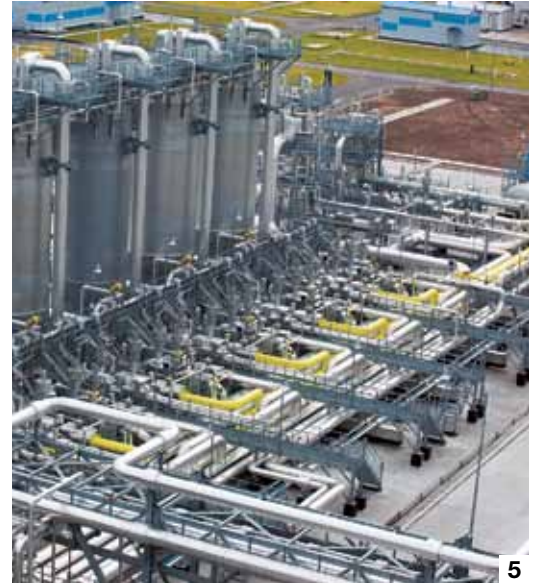
1 ja 2: Kaasunpumpausyksikkö, eli kompressori, jonka voimanlähteenä on Rolls Royce -moottori. 3: Edessä kaasunkäsittelylaitos ja taustalla kahdeksan kompressoriyksikköä. 4 ja 5: Kaasunkäsittelylaitos poistaa lauhdetta kaasusta, joka saapuu Grjazovets-Viipuri-putkilinjaan pitkin.
