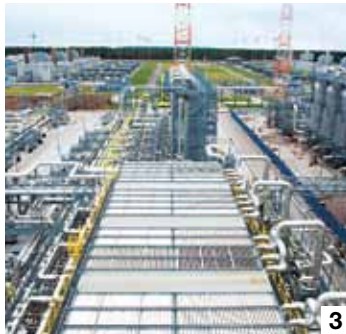
1 ja 2: Kaasunpumpausyksikkö, eli kompressori, jonka voimanlähteenä on Rolls Royce -moottori. 3: Edessä kaasunkäsittelylaitos ja taustalla kahdeksan kompressoriyksikköä. 4 ja 5: Kaasunkäsittelylaitos poistaa lauhdetta kaasusta, joka saapuu Grjazovets-Viipuri-putkilinjaan pitkin.
